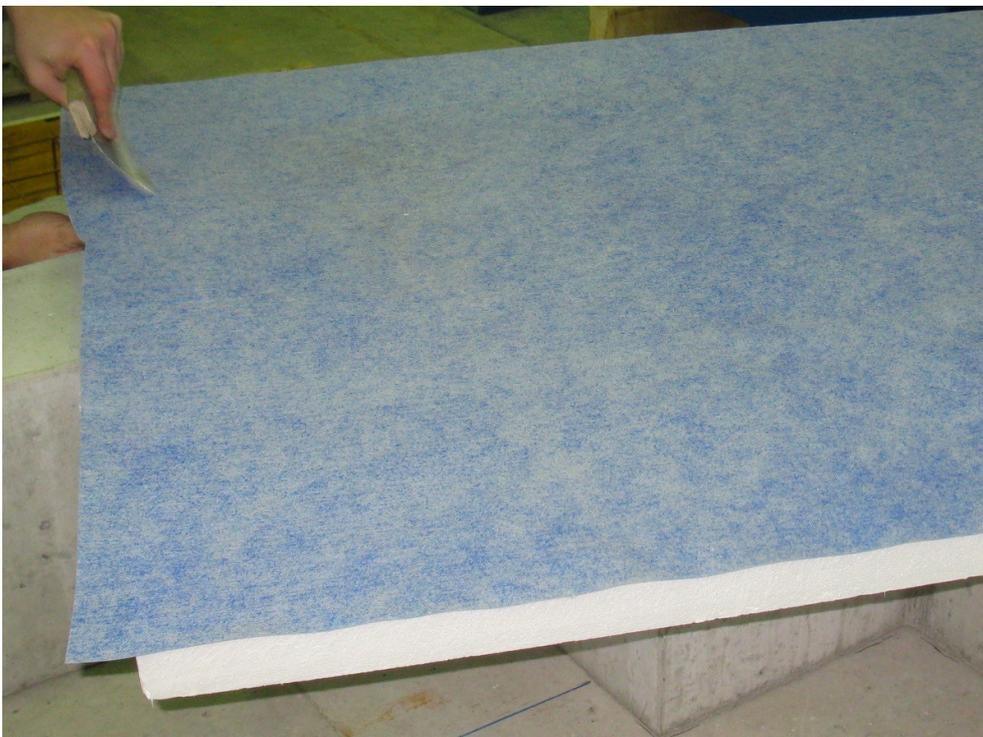
Bild 4 Andrücken der *Saxoboard Abdichtbahn*
