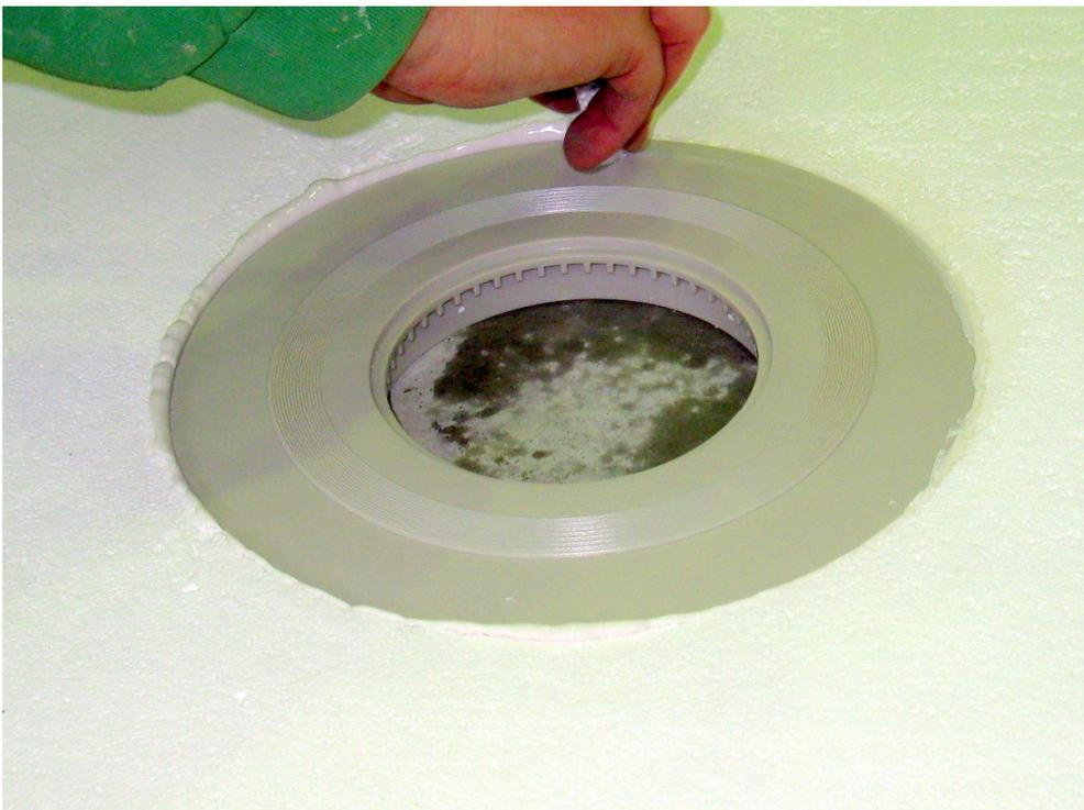
Bild 2 Entfernen des überschüssigen Klebers
