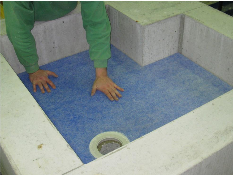
Bild 7 Eindrücken des *Saxoboard Duschelement* mit *Vliesabdichtung* in den *Saxoboard Verbundkleber*
