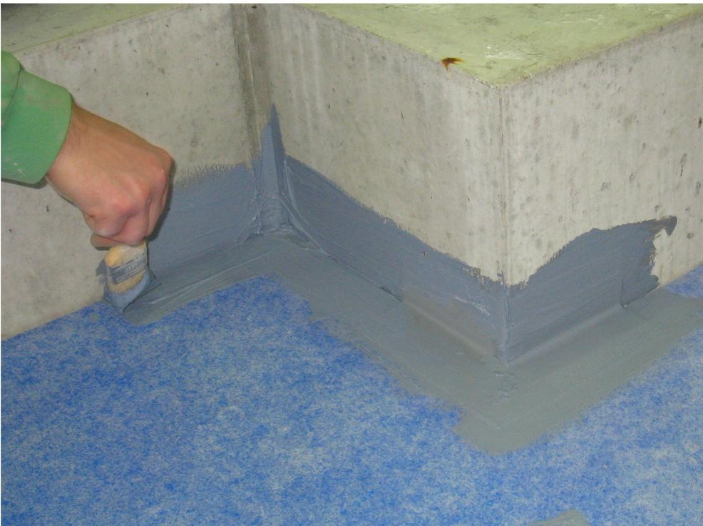
Bild 8 Auftrag der *Saxoboard Flüssigdichtfolie* und Einbau der *Saxoboard Innen- und Außenecken*
