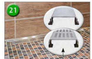
Beim Einsetzen der Roste muss auf die richtige Stellung der Stützfüße geachtet werden (bei Square nach innen, bei Panel und Fliesenmulde nach außen) !
