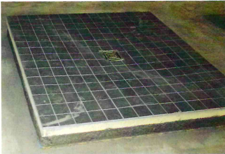
A 3.1: Ansicht Prüfobjekt
